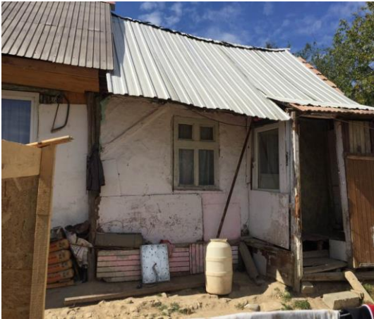
mit unseren Blechen ist das Dach wieder dicht
