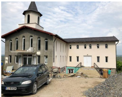
Der Rohbau der Sozialstation ist fertig
