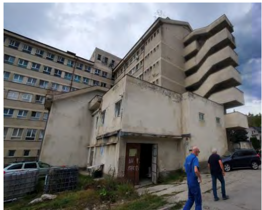
Krankenhaus in Borsa
